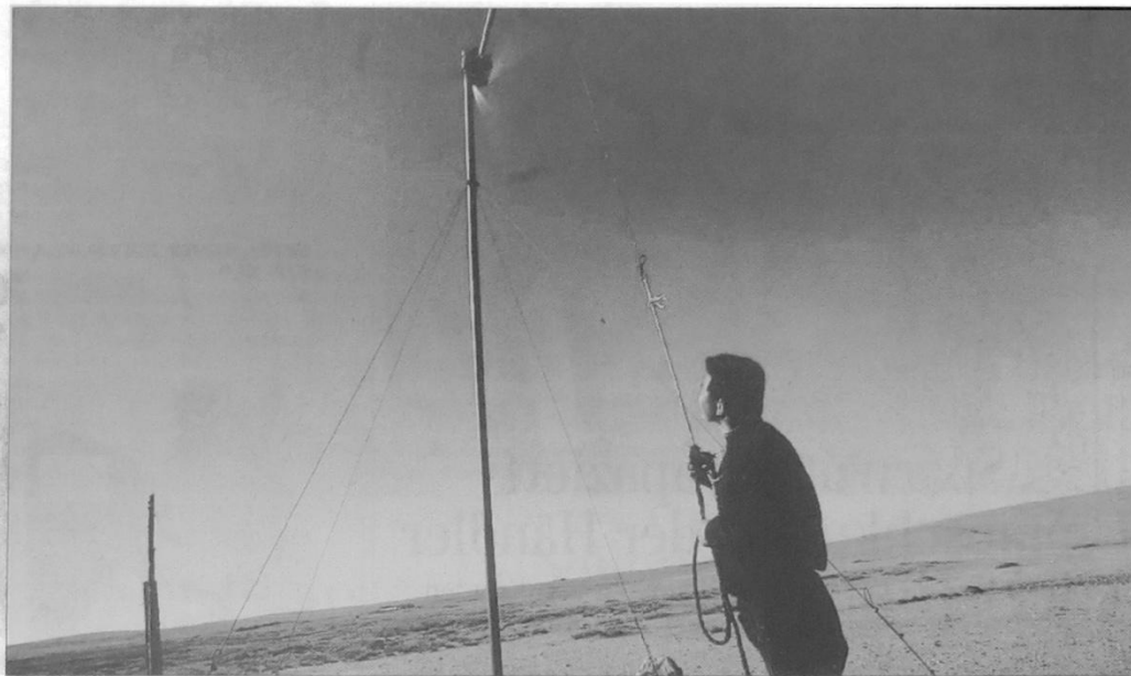
Mit einem Seil wird der Rotor des Windrades auf dem Hof der Familie Bater in die richtige Position gebracht. FOTO: MICHAEL KOTTMEIER
